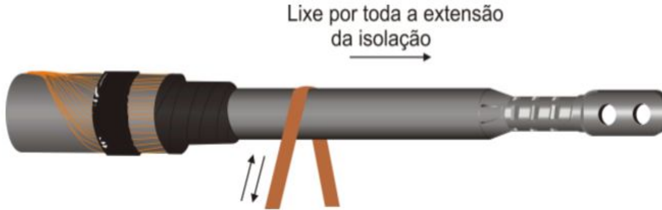
Figura 35. Limpeza do cabo
