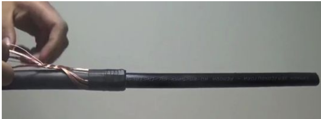
Figura 50. Preparação do aterramento Fonte: http://www.kitacessorios.com.br
