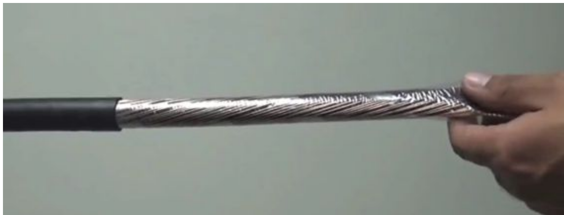
Figura 48. Limpeza e remoção da cobertura do cabo
