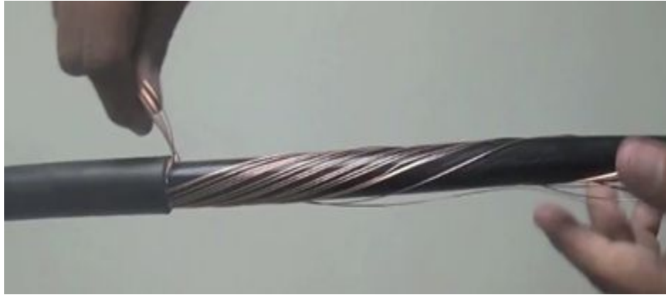
Figura 49. Preparação do aterramento
