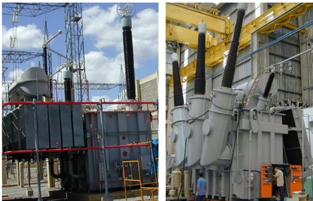
Figura 1: Ilustração de transformador monofásico (à esquerda) e trifásico (à direita)
