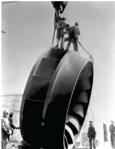
FIGURA 3.7 Turbina Francis na construção da hidrelétrica de Grand Coulee, em 1947, nos Estados Unidos.
