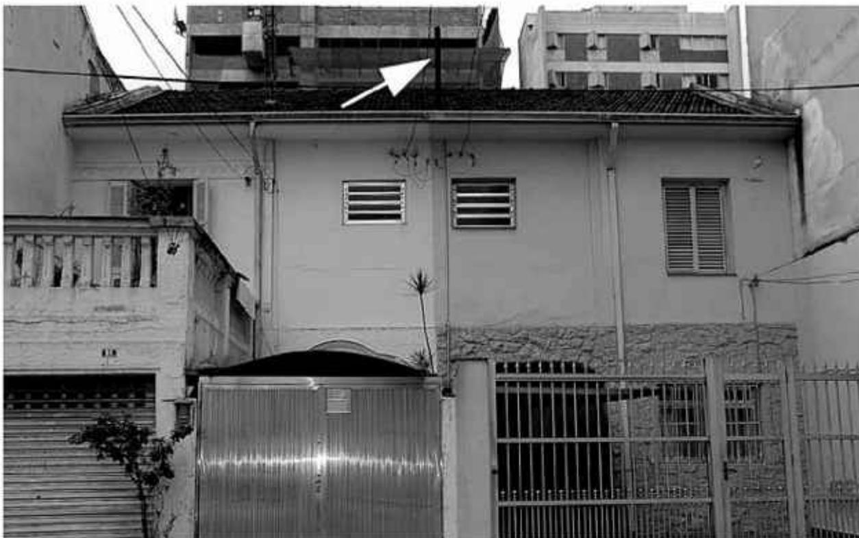
**Caso curioso de condomínio informal. Duas casas e um único sistema de ventilação das instalações prediais de esgoto sanitário. Se quisermos demolir uma casa teremos que demolir a ventilação do sistema de esgoto da outra? Relembrando que o sistema de ventilação de esgotos tem a finalidade de fazer funcionar melhor o escoamento dos esgotos**
