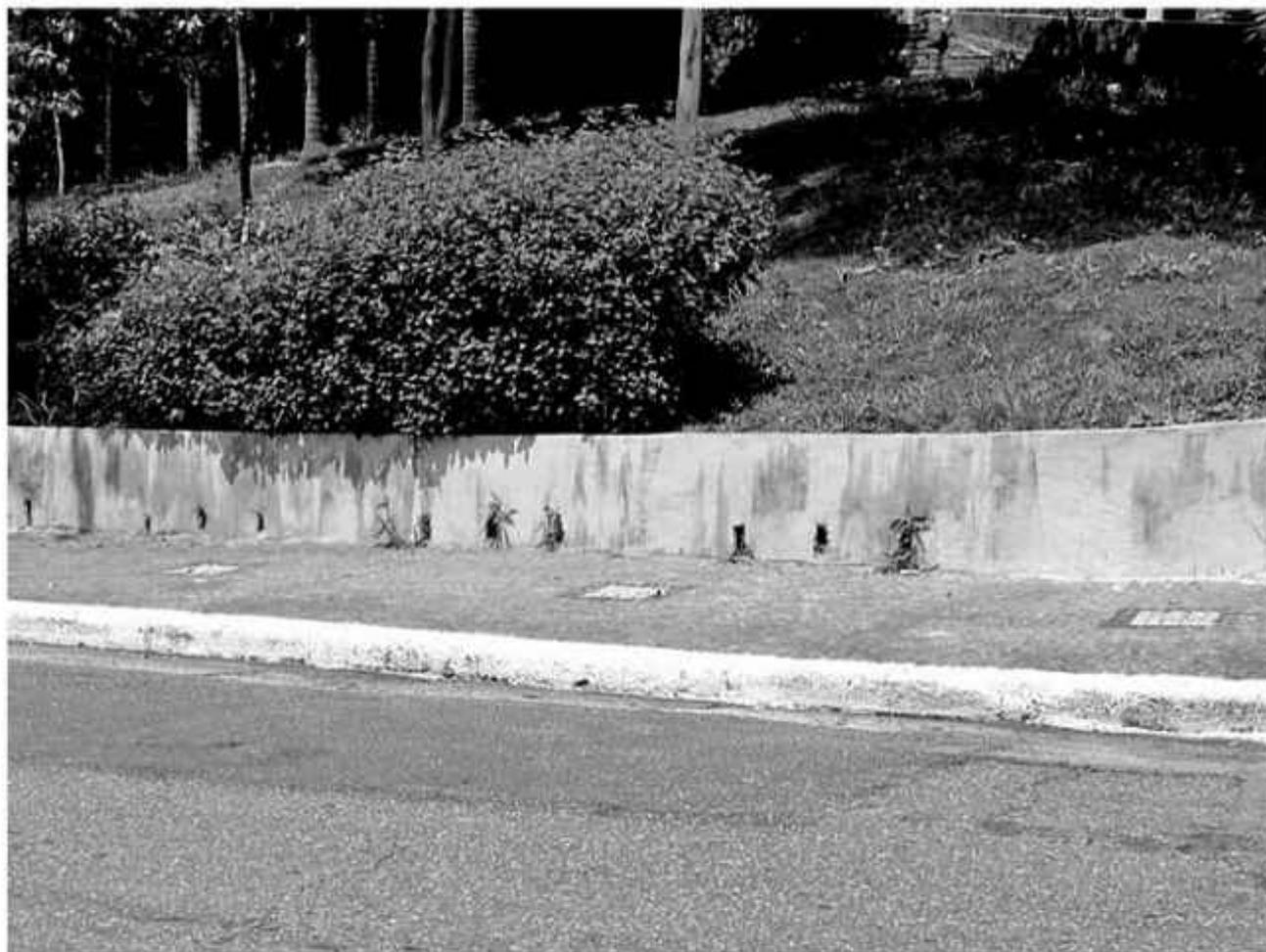
Apesar da pouca altura (cerca de 80 cm) do muro de arrimo, veja os cuidados com a drenagem: *simples orifícios de alvenaria, mas funcionam.*
