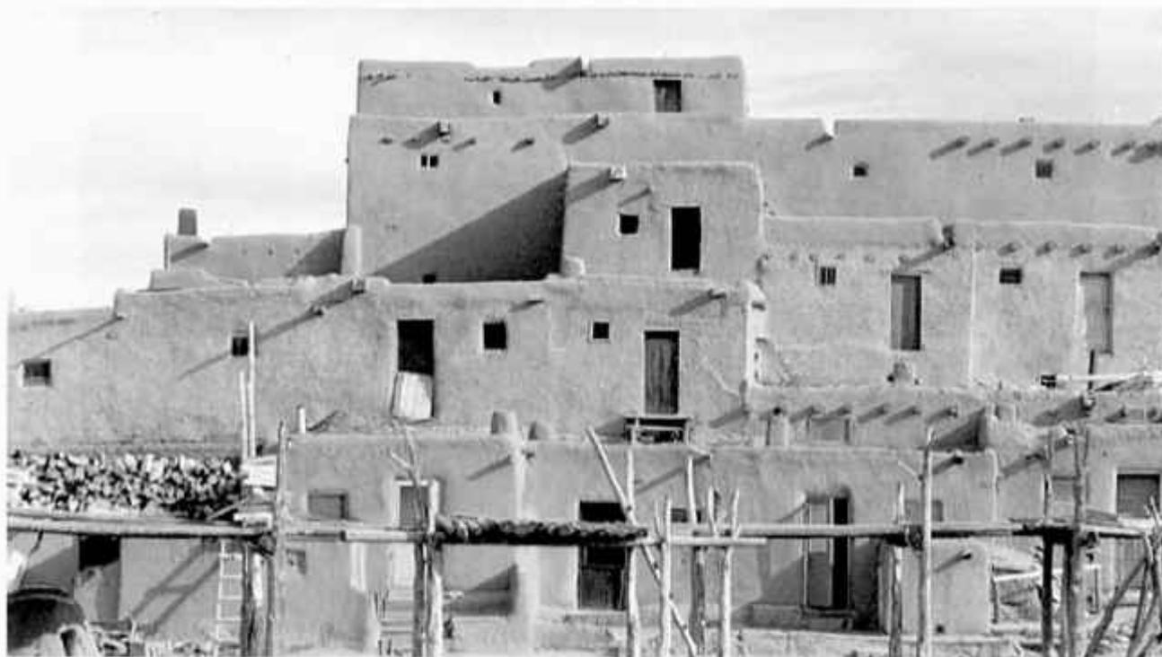
**Residência usando o barro (argila) junto com madeira. Só viável em regiões de baixa pluviosidade.**
