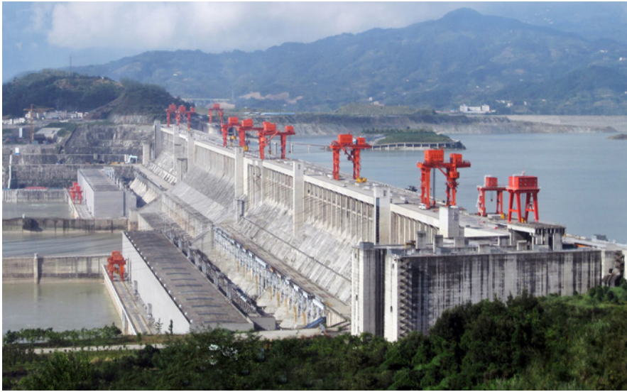
Figura 1.4 – Usina hidrelétrica de Três Gargantas.
