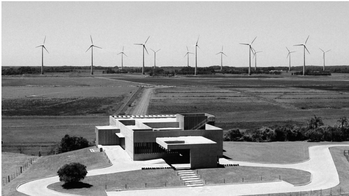
Parque eólico de Osório (RS). (Cortesia da Enerfín, Espanha.)
