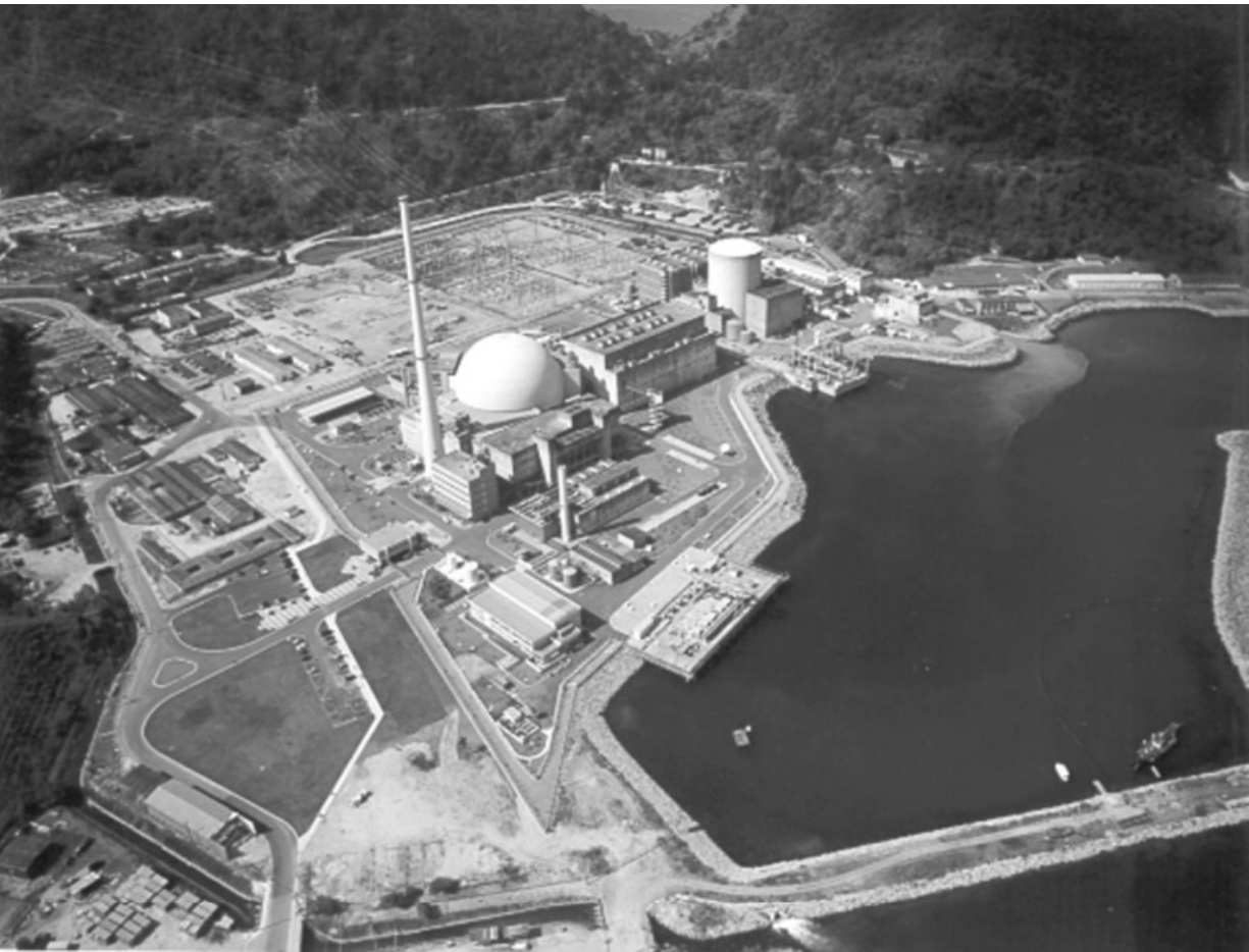
Usina nuclear de Angra 2. (Divulgação Eletronuclear.)
