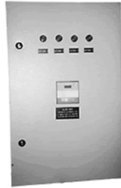
Painel do banco automático
