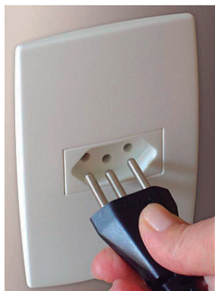
Plugue de equipamentos classe I (plugue 2P+T)
