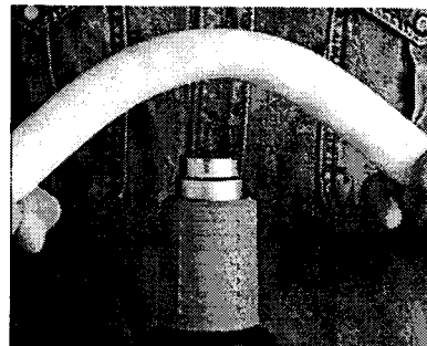
Figura 3.40 - Curvar tubos de PVC. Cortesia: Comala/Steinel.
