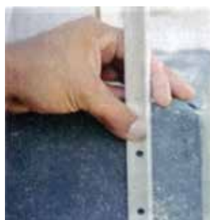
Fig 24 - Fixação de haste no muro
