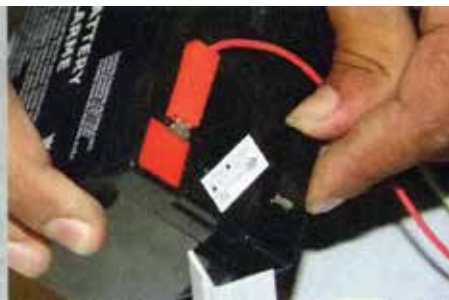
Fig 57b - Instalando a bateria
