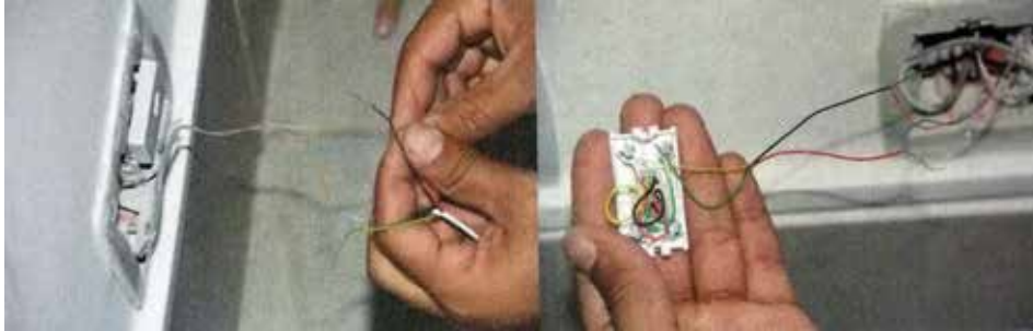
Fig 81 - Ligação na linha telefônica
