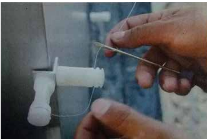
Fig 33a - Fazendo o anel com a chave de fenda
