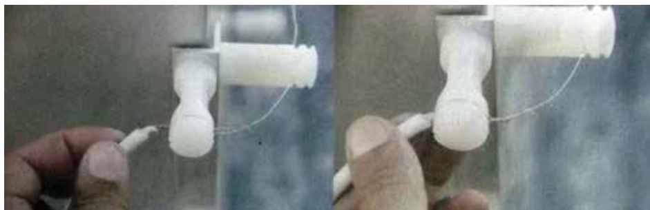
Fig 38a - Passando o cabo no isolador
