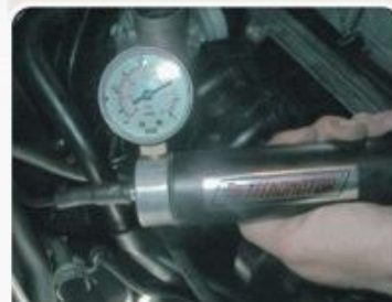
F.1.3 - Bomba de pressão instalada.
