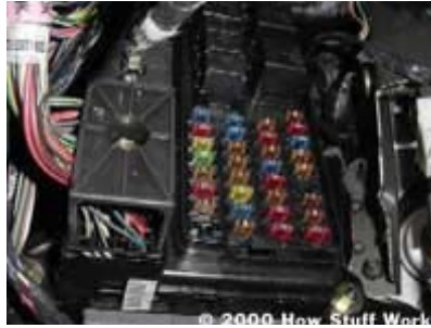
Painel de fusíveis no interior
