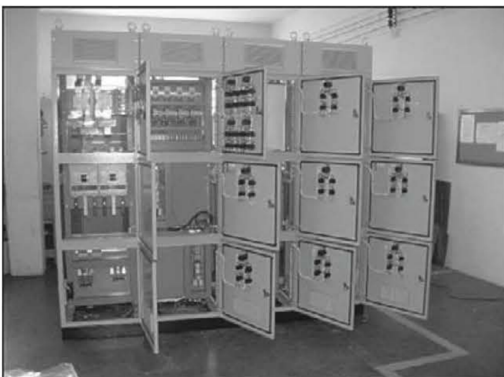
FIGURA A.2.3 CCM não-compartmentado, vistas interna e externa. Cortesia: Indústria e Comércio Lavill Ltda.
