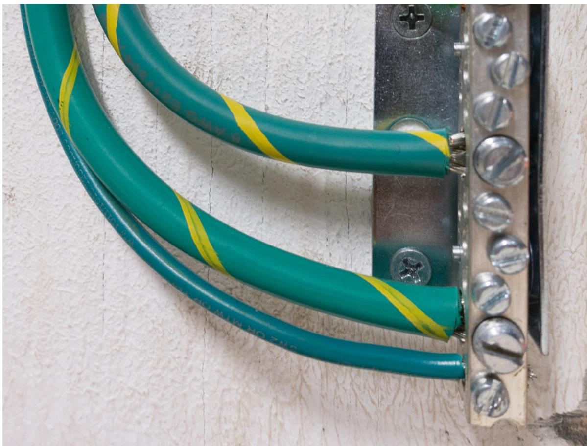
Para evitar que esse potencial “flutue”, ligamos (logo na entrada) o fio neutro a uma haste de terra. Sendo assim, qualquer potencial que tender a aparecer será escoado para a terra.
