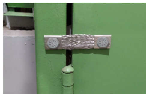
Figura 10 - Ligação equipotencial direta. Fonte: Autor/2021.
