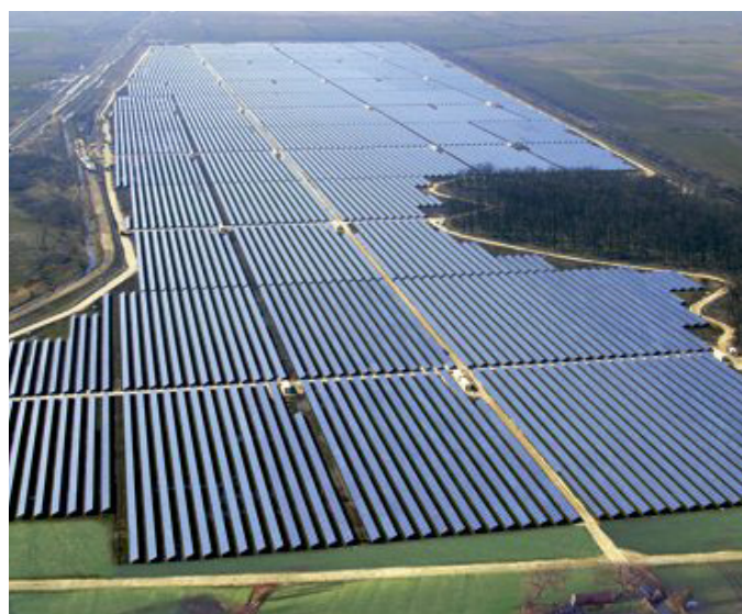
Figura 25 - Usina fotovoltaica tipo solo. Fonte: GTEL/2022.
