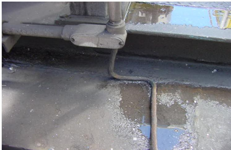
Fig 61 Condutores com raio de curvatura inferior a 200mm
