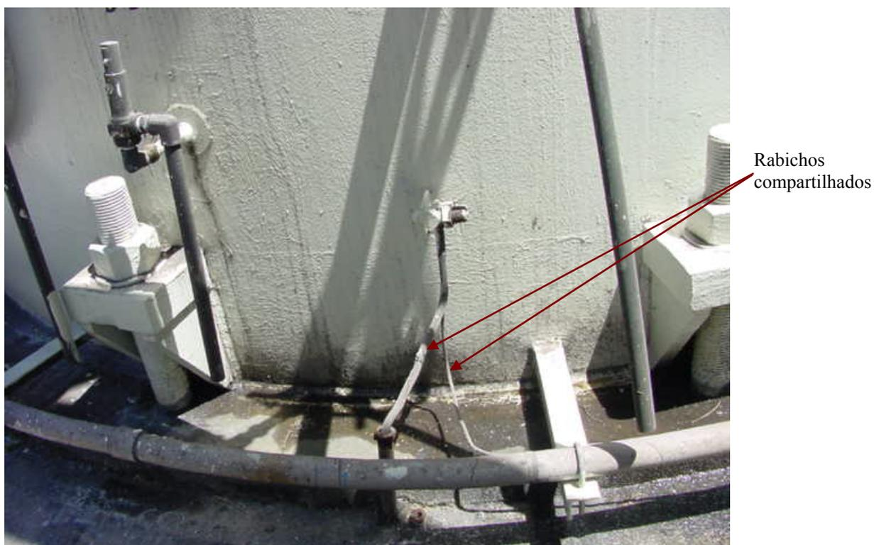
Fig 60 Rabichos de SPDA e aterramento compartilhados
