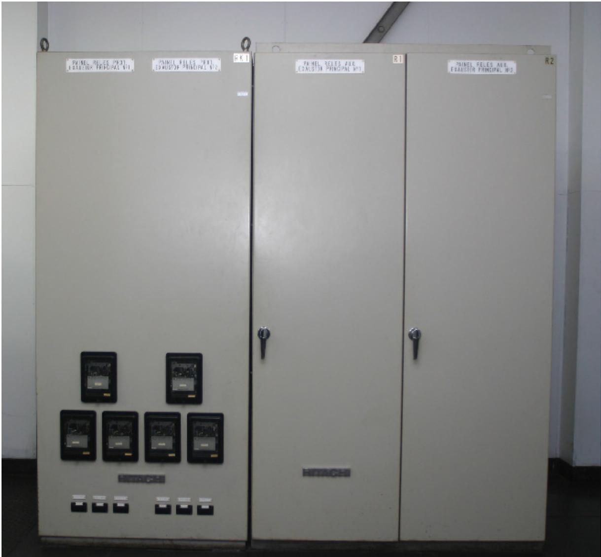
Fig 11 Proteção diferencial de motor de média tensão
