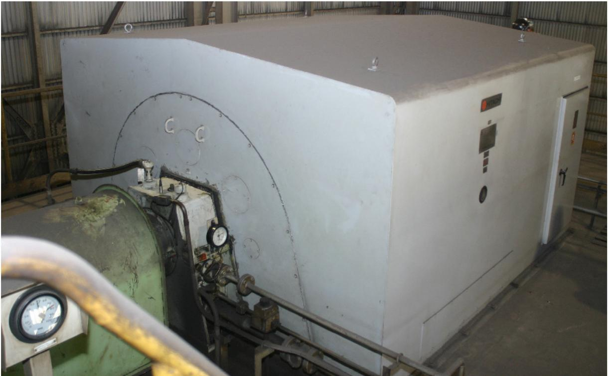
Fig 32 Motor de média tensão de 13,2 kV
