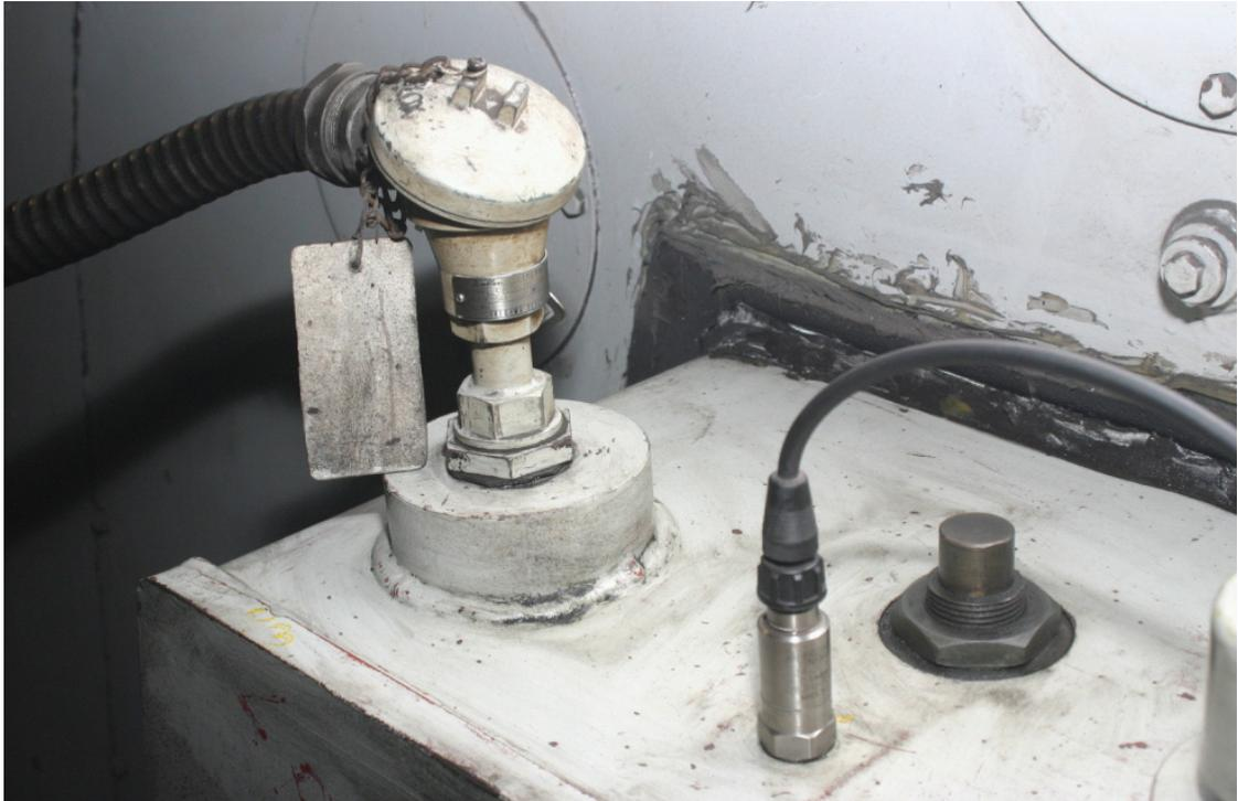
Fig 19 Sensores de vibração e temperatura de mancal de motor de média tensão
