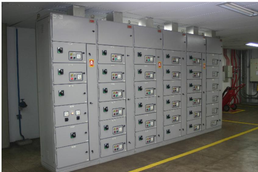
Fig 1 Centro de controle de motores (CCM)
