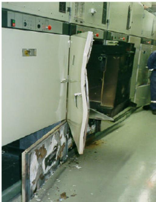
Fig 95 Danos causados em um cubículo devido ao arco voltaico
