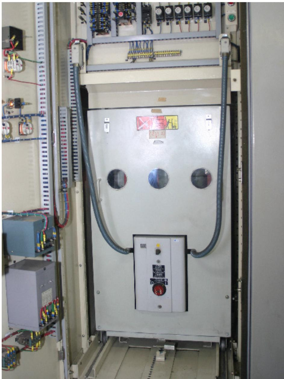
Fig 96 Disjuntor extraível em posição inserido
