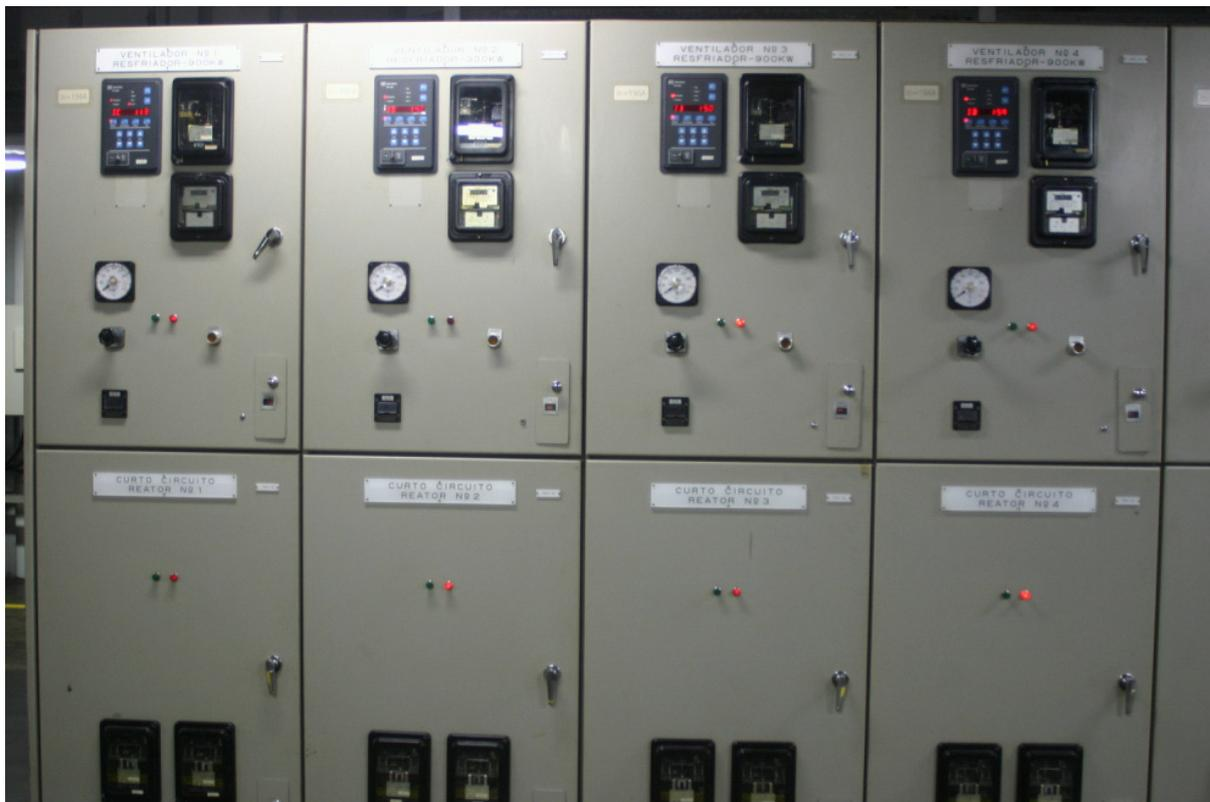
Fig 91 Centro de Controle de Motores de Média Tensão
