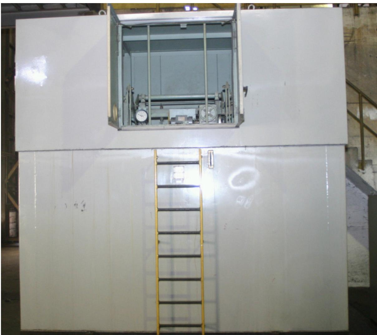
Fig 70 Reostato líquido para partida de um motor de 7000 kW, 13,2kV
