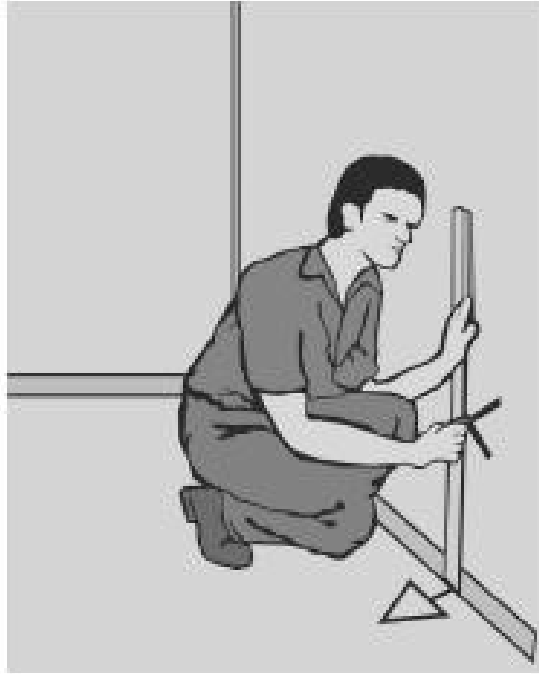
Figura 127 – Marcação do ponto de tomada na parede.
