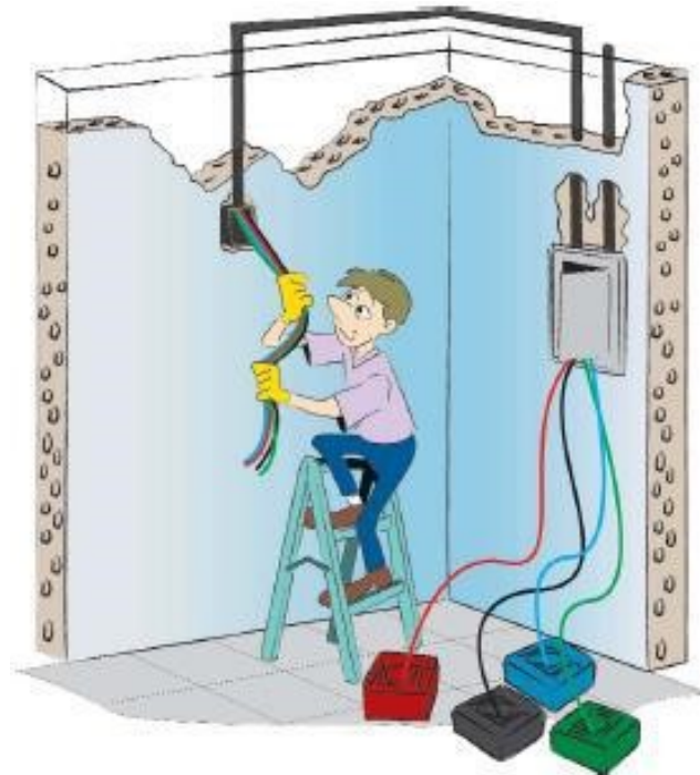
Figura 101 – Tracionando condutores.
