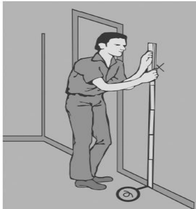
Figura 131 – Marcação da posição do interruptor na parede.
