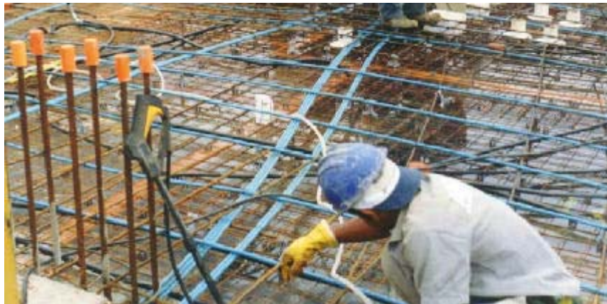
Exemplos de cordoalhas em uma laje
