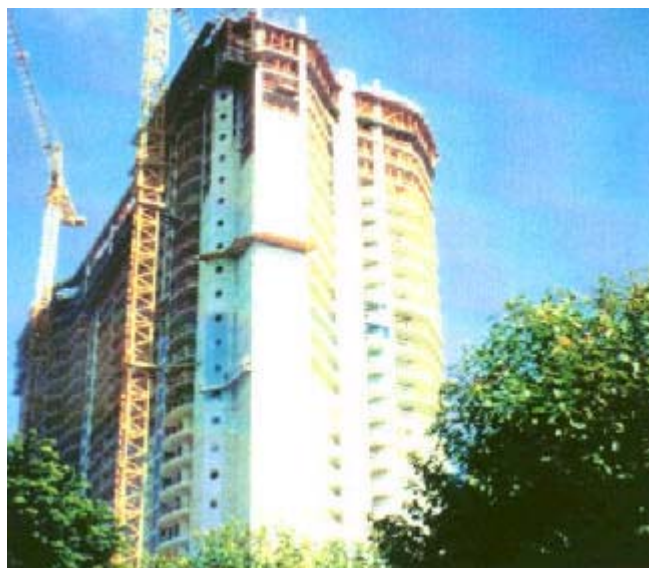
Execução de fachada em conjunto com a estrutura.
