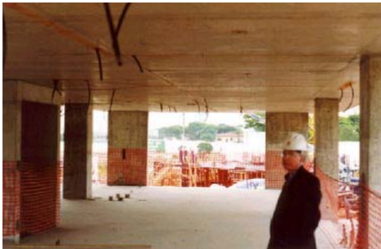
Laje sem vigas e com piso acabado
