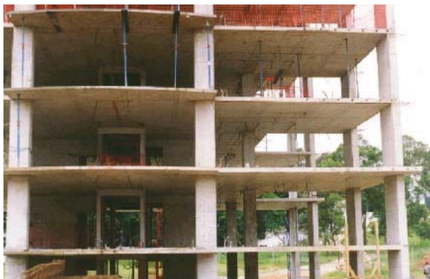
Edifício Residencial sem vigas
