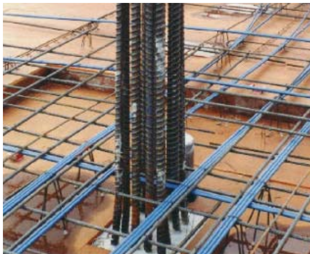
Armação do pilar engarrafada.
