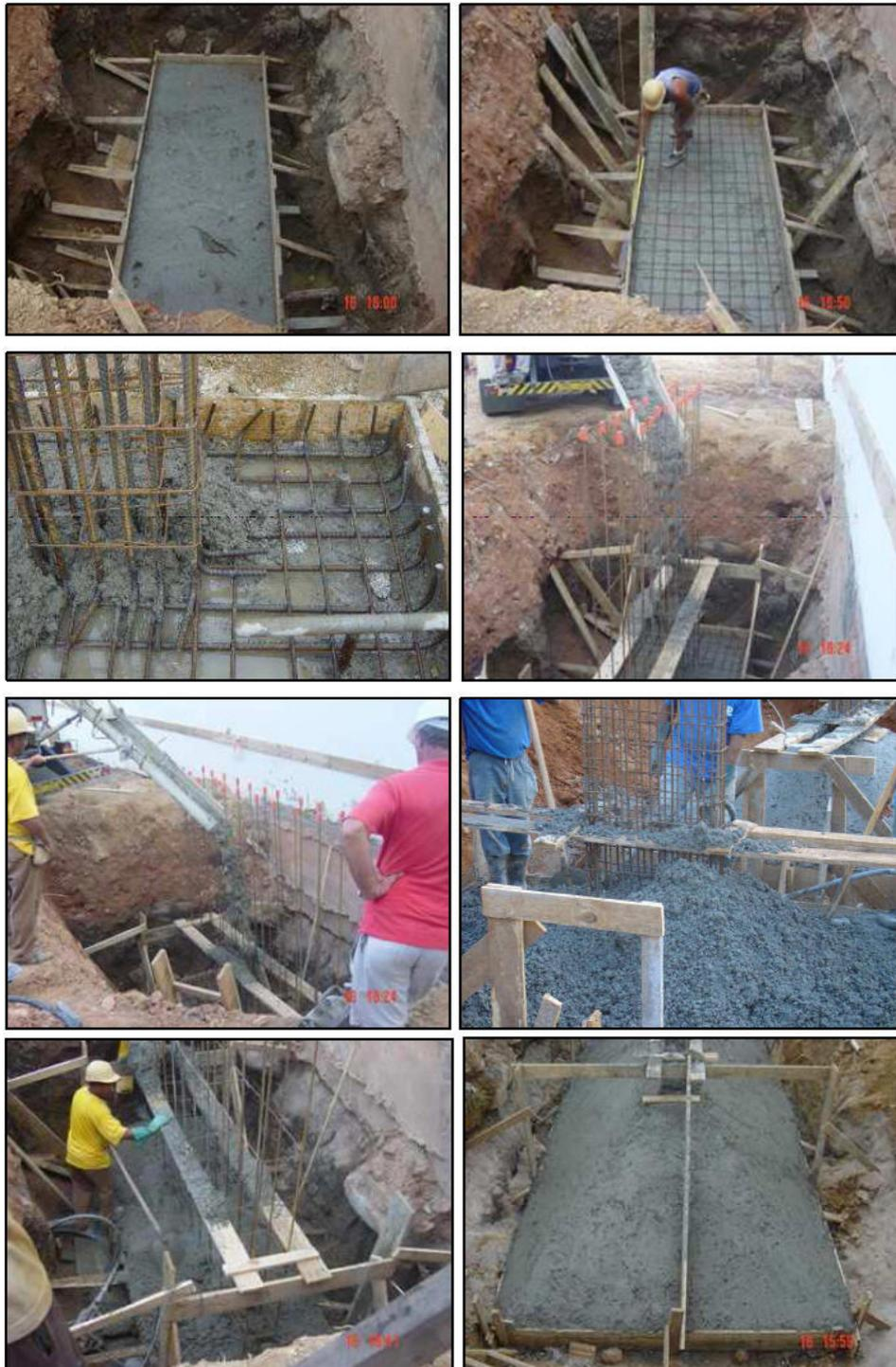
Figura 15 – Seqüência construtiva de uma sapata isolada.
