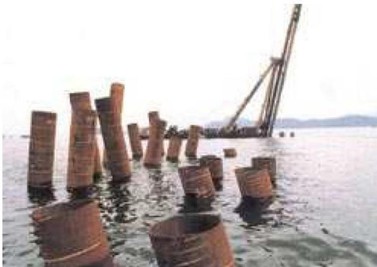
Figura 30 - Tubos de cravação de estacas submersas.
