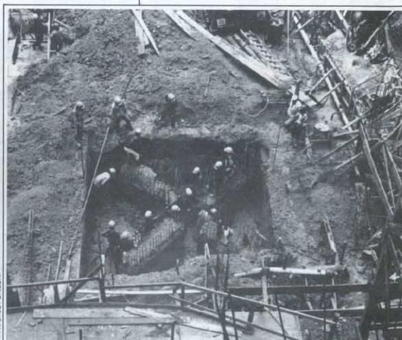
**Estacas-barrete moldadas in loco com profundidade de até 55 m**
