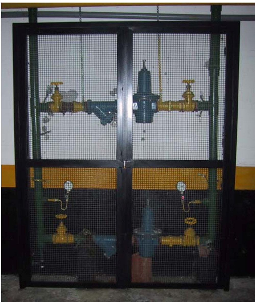
Foto 2 - Proteção da Estação Redutora de Pressão
