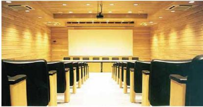
Figura 5. Forro e paredes em madeira.
