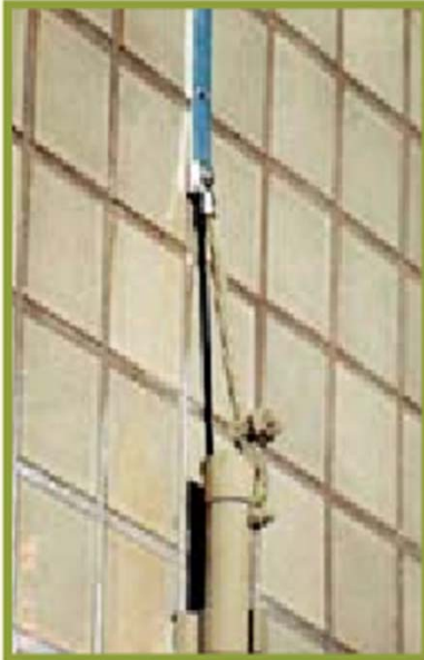
Descida com barra chata de alumínio, conector de compressão bimetálico e tubo metálico
