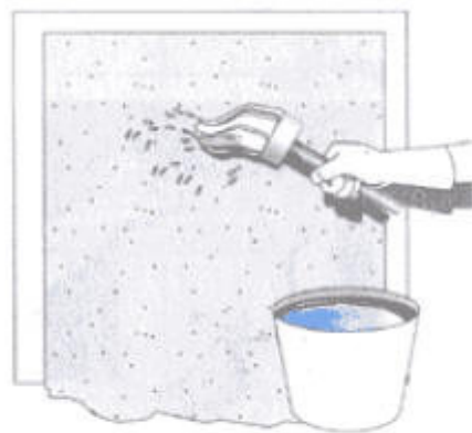
Figura 17. Molhar a camada de emboço.
