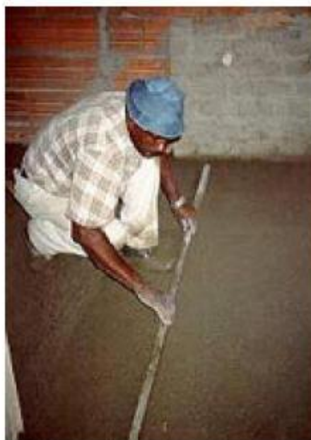
Figura 2. Sarrafeamento das superfícies.
