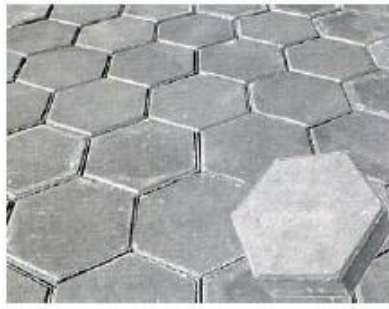
Figura 19. Piso intertravado (tipo paver).
