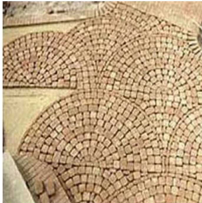
Figura 20. Piso articulado (tipo bloket).
