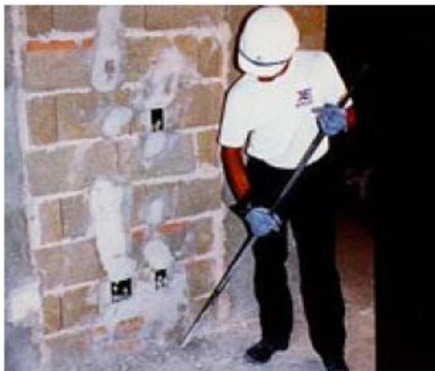
Figura 1. Retirada de entulhos com ponteira.
