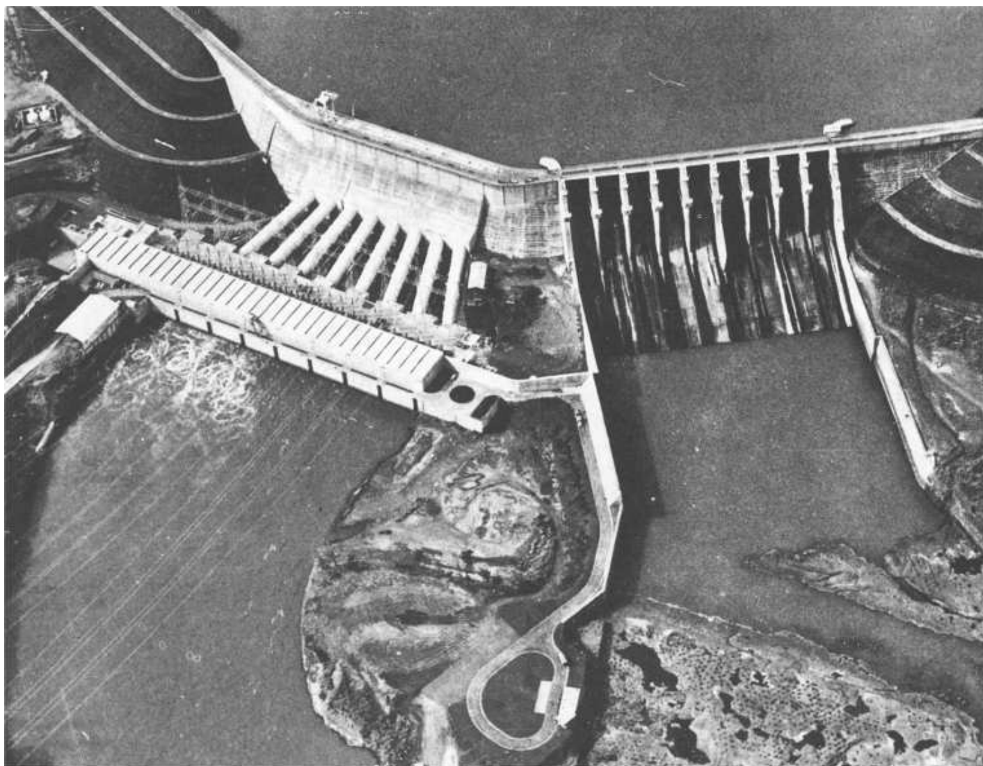
Usina hidrelétrica de Marimbondo — Foz de Iguaçu, com oito geradores de 180 MVA.
