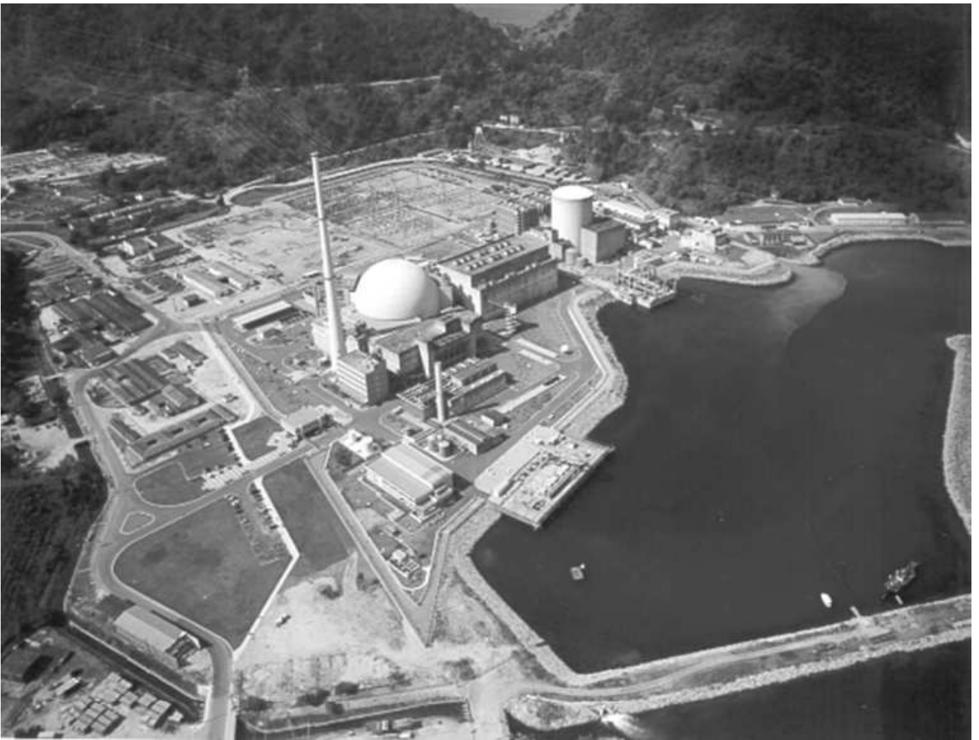
Usina nuclear de Angra 2. (Divulgação Eletronuclear.)
