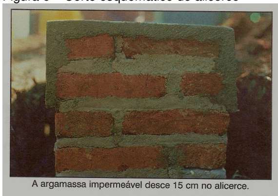
Figura 7 – A argamassa impermeável no alicerce
