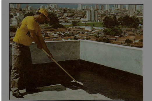
Figura 12 - Aplicação da membrana asfáltica
