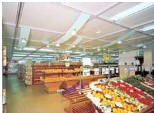
Figura 7 - Exemplo de iluminação geral - Supermercado
