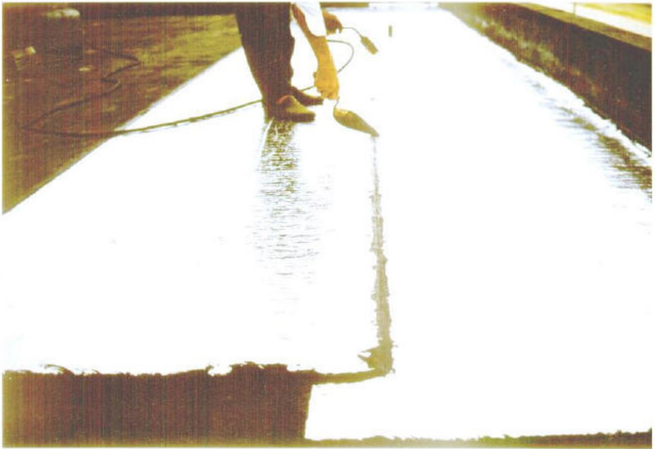
Figura 16. Pintura das juntas.
