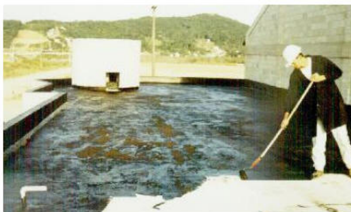
Figura 13. Imprimação asfáltica.
