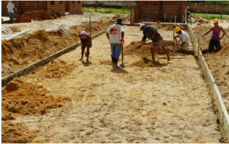
Preparo do terreno: acerto manual, colocação das tubulações de água e esgoto e formas laterais
