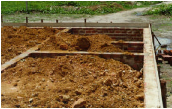
Alvenaria, forma, cinta e reatêro manual
