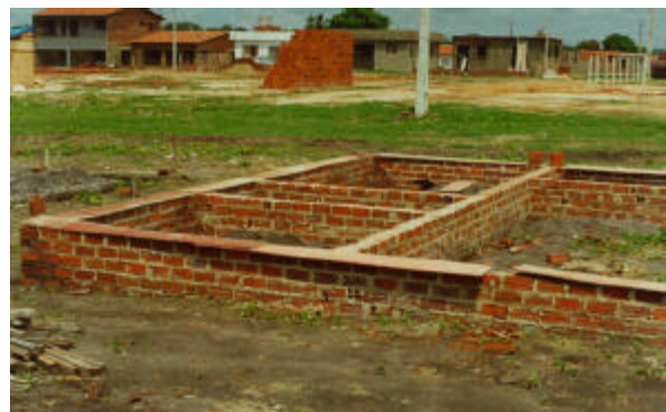
Base de alvenaria de tijolos
