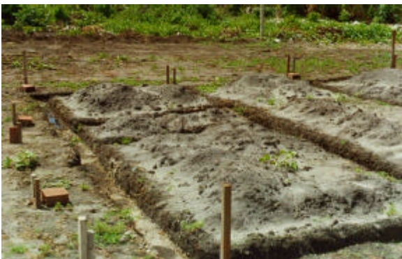
Escavação e nivelamento das valas
