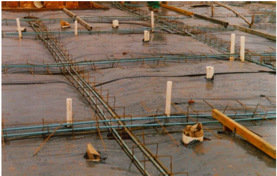
Cabos colocados nas nervuras cavadas no terreno
