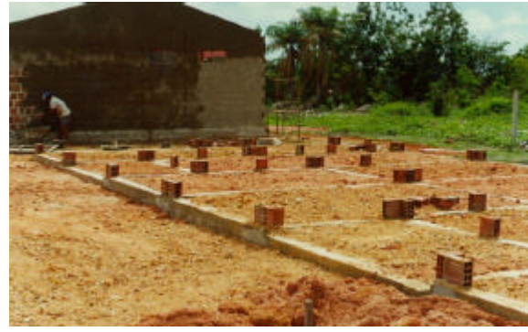
Reatêro apiloado, antes do contrapiso (5cm)
