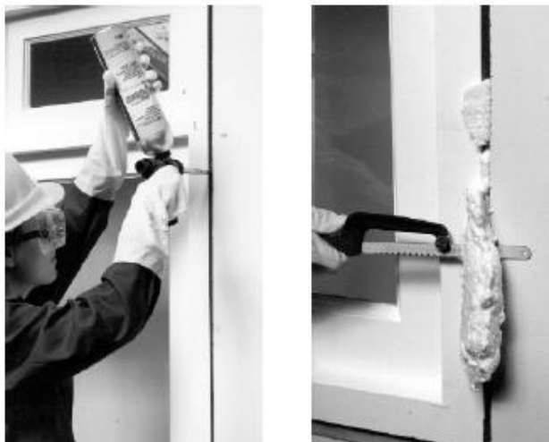
Figura 20. Aplicação e acabamento de fixação de esquadria com espuma expansiva.
