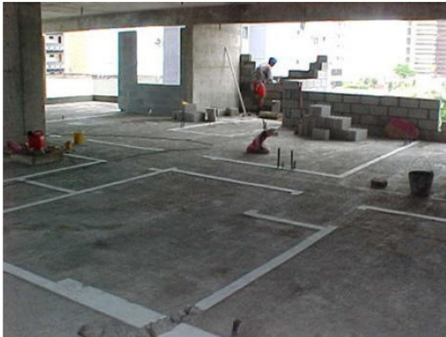
Figura 14. Marcação de parede de alvenaria no piso.
