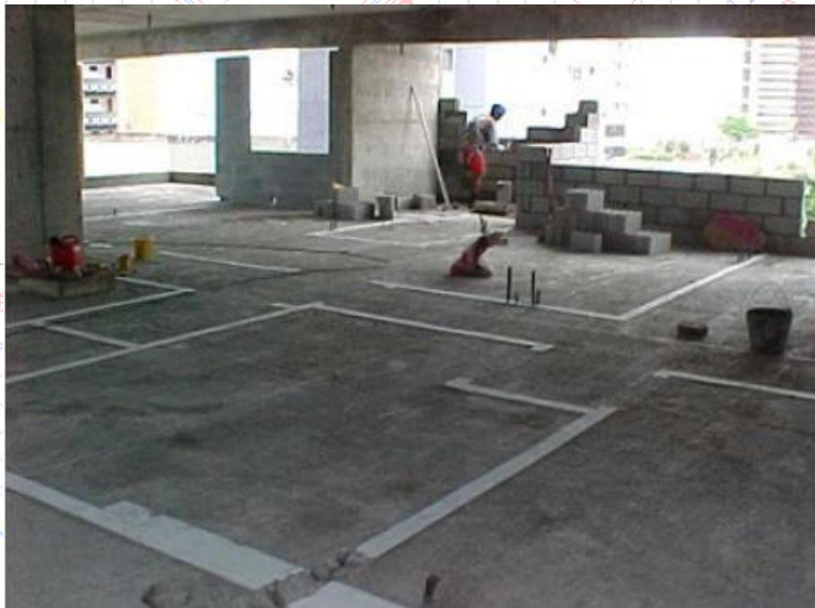
Figura 14. Marcação de parede de alvenaria no piso.
