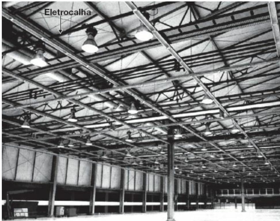
**Figura 2.28** Iluminação de um galpão industrial com proje tores.
