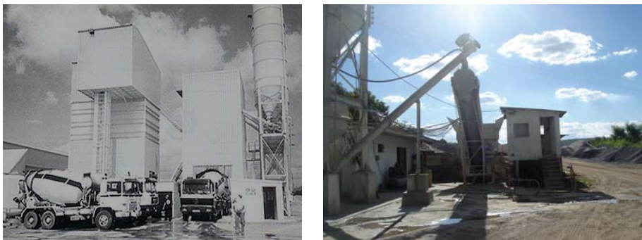
Centrais dosadoras de concreto
