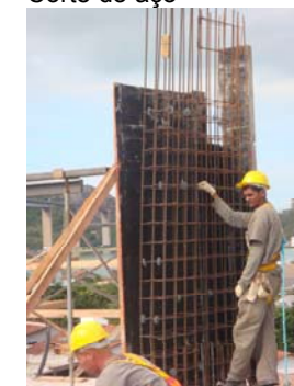
Colocação da ferragem
