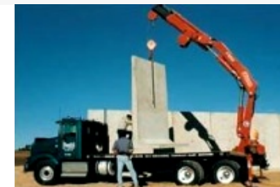
lçamento de peça pré-fabricada
