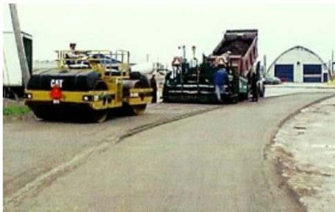
Aplicação do concreto rolado
