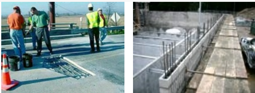
Detalhes do groutamento
