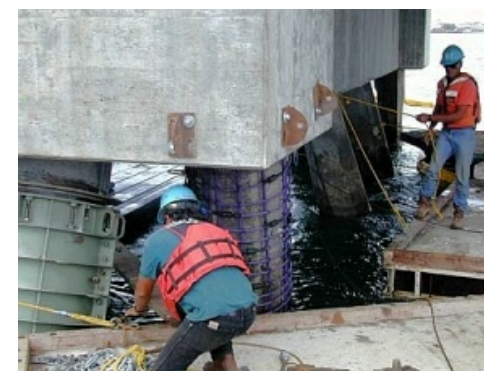
Fundação de ponte
