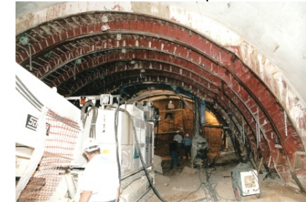
Forma em túnel
