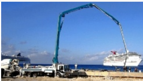
Bombeamento de concreto
