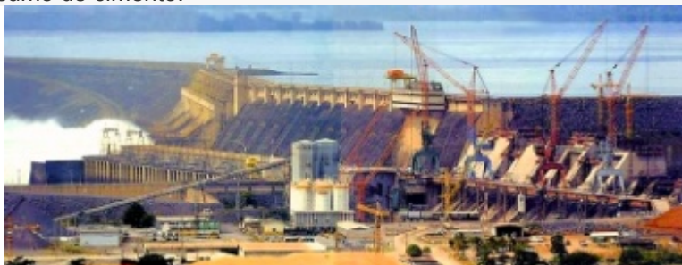
Construção de usina hidrelétrica
