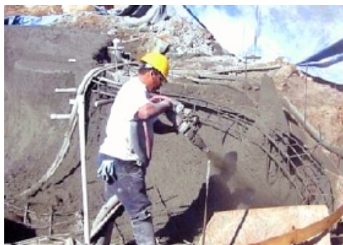
Projeção de concreto
