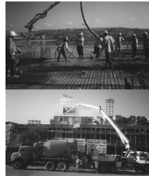
Transporte e lançamento de concreto
