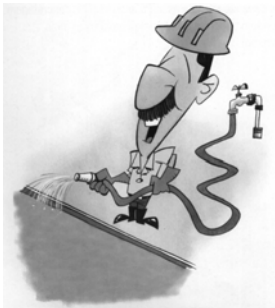
Cura do concreto
