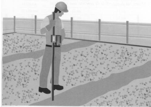
Nívelamento da laje
