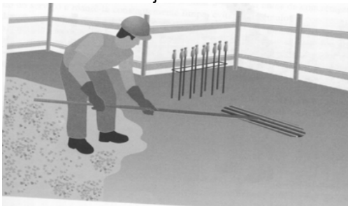
Alisamento do concreto da laje
