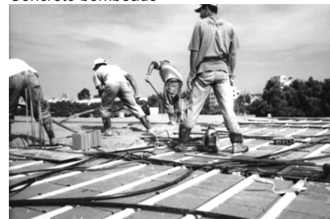
Laje pré fabricada com lajotas cerâmicas e uso de concreto bombeado
