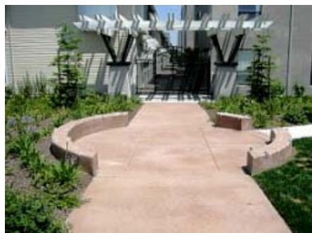
Piso em concreto colorido
