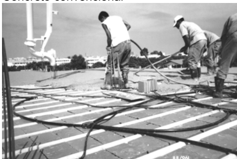
Laje pré fabricada com lajotas cerâmicas e uso de concreto bombeado
