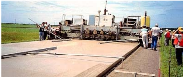
Aplicação do concreto de pavimentação rígida
