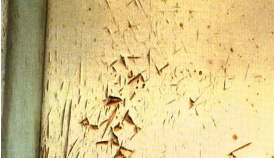
**Figura 31. Trincas na madeira.**
