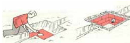
Figura 31. Construção da caixa de inspeção.
