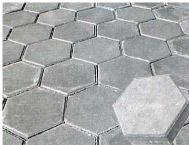
Figura 19. Piso intertravado (tipo paver).
