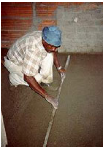
Figura 2. Sarrafeamento das superfícies.
