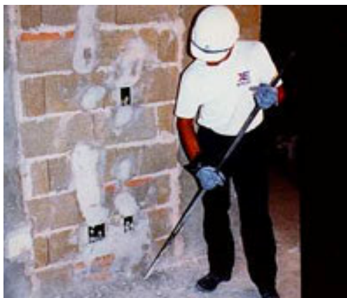
Figura 1. Retirada de entulhos com ponteira.
