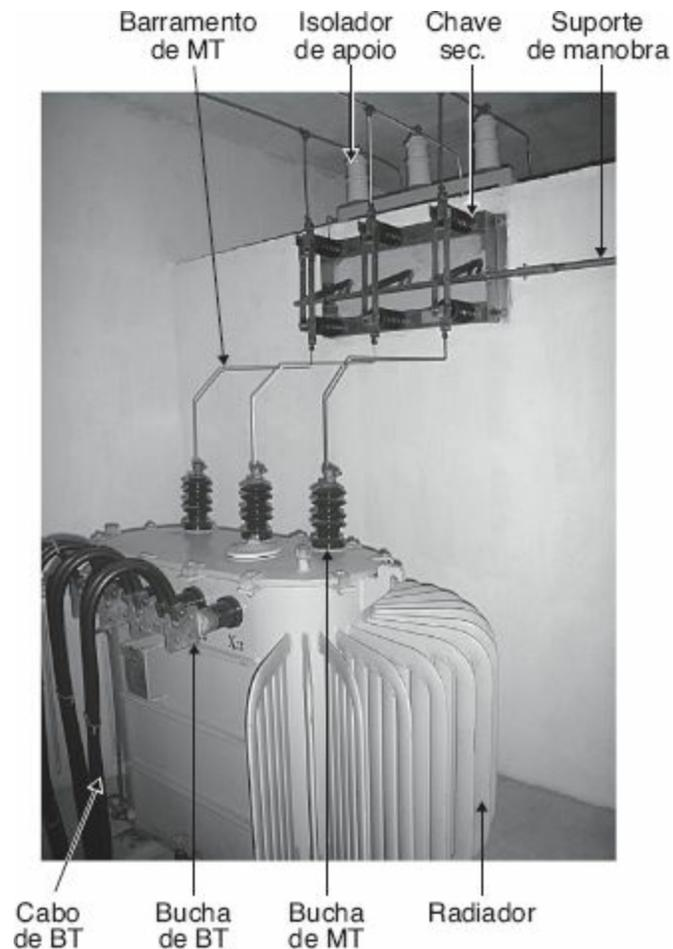
**Figura 12.7** Cubículo de transformação de uma subestação em alvenaria.
