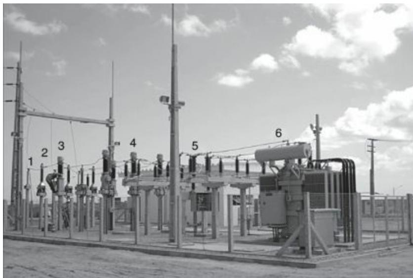
1 - Para-raios; 2 - Transformador de potencial; 3 - Transformador de corrente; 4 - Disjuntor tripolar; 5 - Chave seccionadora; 6 - Transformador de potência
