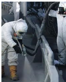
Jato de granalha
