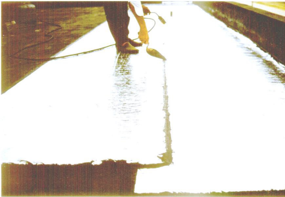
Figura 16. Pintura das juntas.
