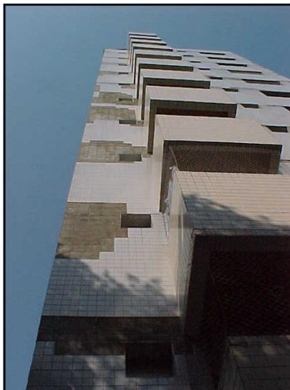
Placas cerâmicas que se destacam do emboço que permanece completamente aderido.
