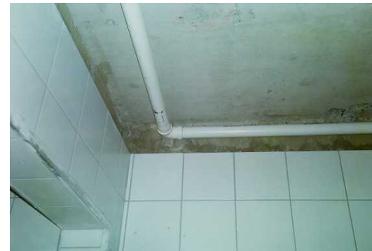
EMBUTIMENTO NO FORRO
