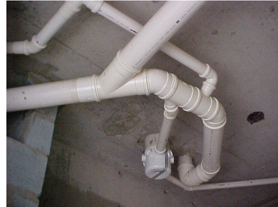
EXECUÇÃO DO ESGOTO
