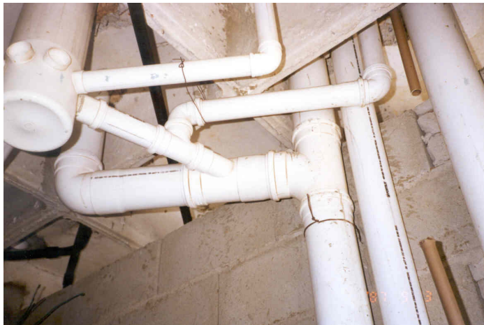
EXECUÇÃO DO ESGOTO
