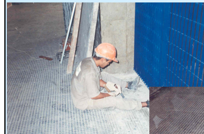
Retirada de piso de borracha
