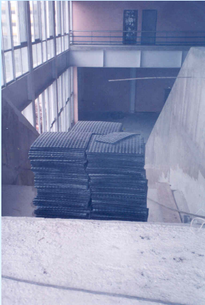
Estoque de piso de borracha
