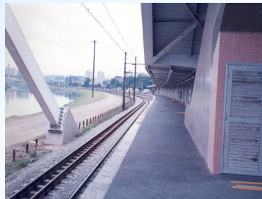
Piso de borracha já colocado
