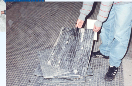
Piso de borracha já retirado
