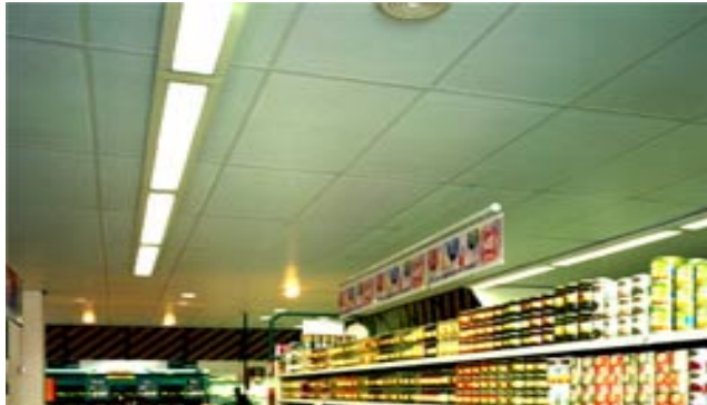
COM ESTRUTURA APARENTE
