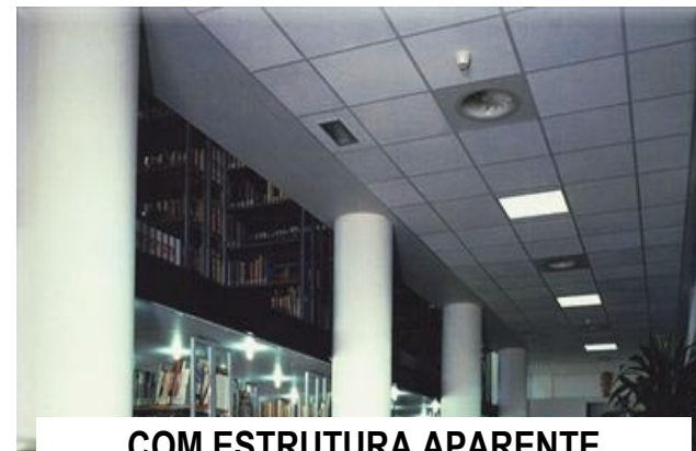
COM ESTRUTURA APARENTE
