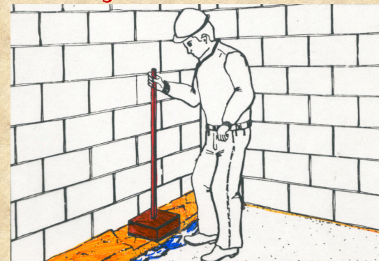
COMPACTAÇÃO DA MESTRA
