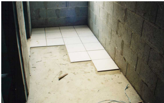
REVESTIMENTO DE PISO
