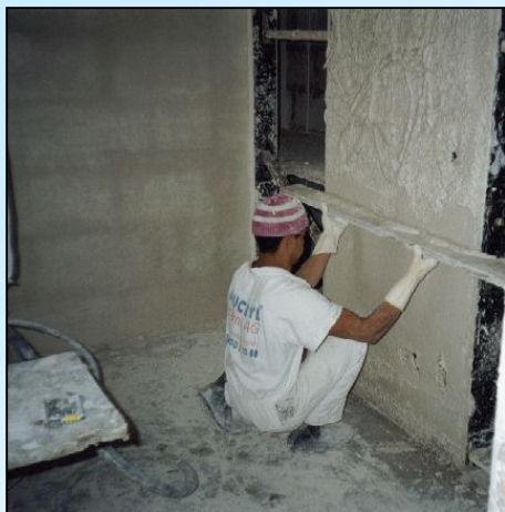
Aplicação de revestimento de gesso “sarrafeado”
