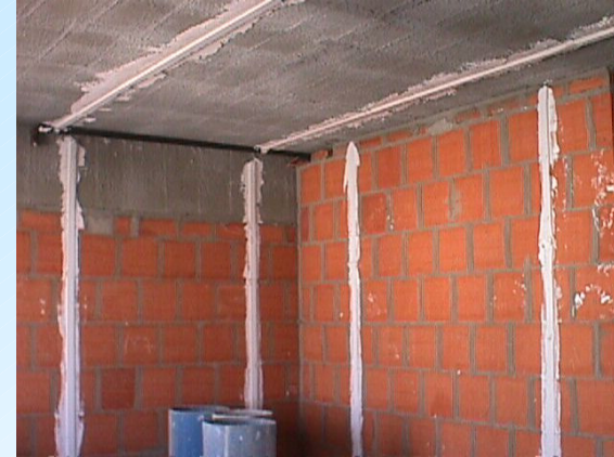
Preparação para aplicação de revestimento de gesso “sarrafeado” (com mestras)
