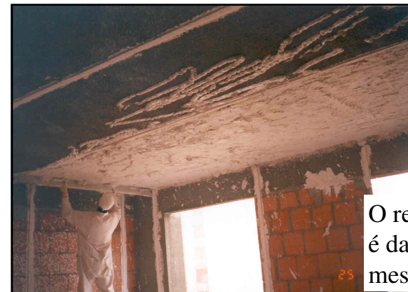
Aplicação de revestimento de gesso “sarrafeado”
